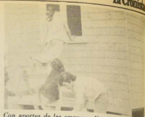
Con aportes de las empresas Forestal Arauco y Celulosa Arauco se están construyendo 10 viviendas sociales en la Población 11 de Septiembre de la comuna de Lebu.
