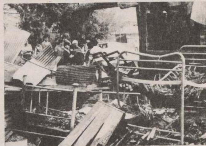
Bomberos investiga las reales causas del siniestro. Se estima que una falla en el sistema eléctrico habría originado el fuego.
