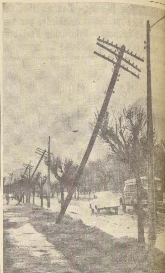
EN AVENIDA SANTA MARIA, al lado del río Mapocho, la postación de telégrafos quedó seriamente dañada. EL GRABADO muestra la hilera de postes de madera caídos por el fuerte impacto del viento. Los cables quedaron inutilizados y la Compañía de Telégrafos tuvo que realizar reparaciones de urgencia.
