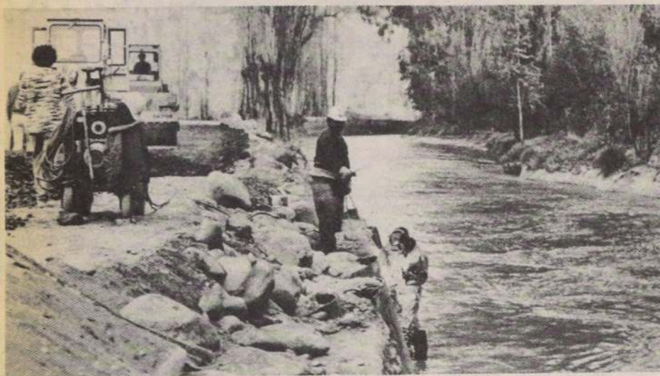
NORMALIZADO CANAL SAN CARLOS. — Totalmente normalizado quedó el canal San Carlos, luego que ingenieros y técnicos de la firma constructora Jara y Gumucio, repararan la filtración que se originó 237 metros aguas abajo de los tubos desripadores del cauce que nace en el río Maipo. Las aguas comenzaron a fluir en forma medida desde la bocaneta de éste, situada en el sector de Las Vertientes en la comuna de San José de Maipo, a las 18.00 horas del lunes, para prevenir deterioros en las estructuras de refuerzo instaladas pasado el mediodía del mismo lunes. Ayer se efectuaron los últimos detalles y soldadura de refuerzos, para lograr la absoluta normalización de su cauce hoy.
