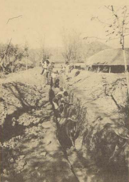
LIPIEZA DE CANALES: una de las nuevas fuentes de trabajo para centenares de cesantes en todo el país.
