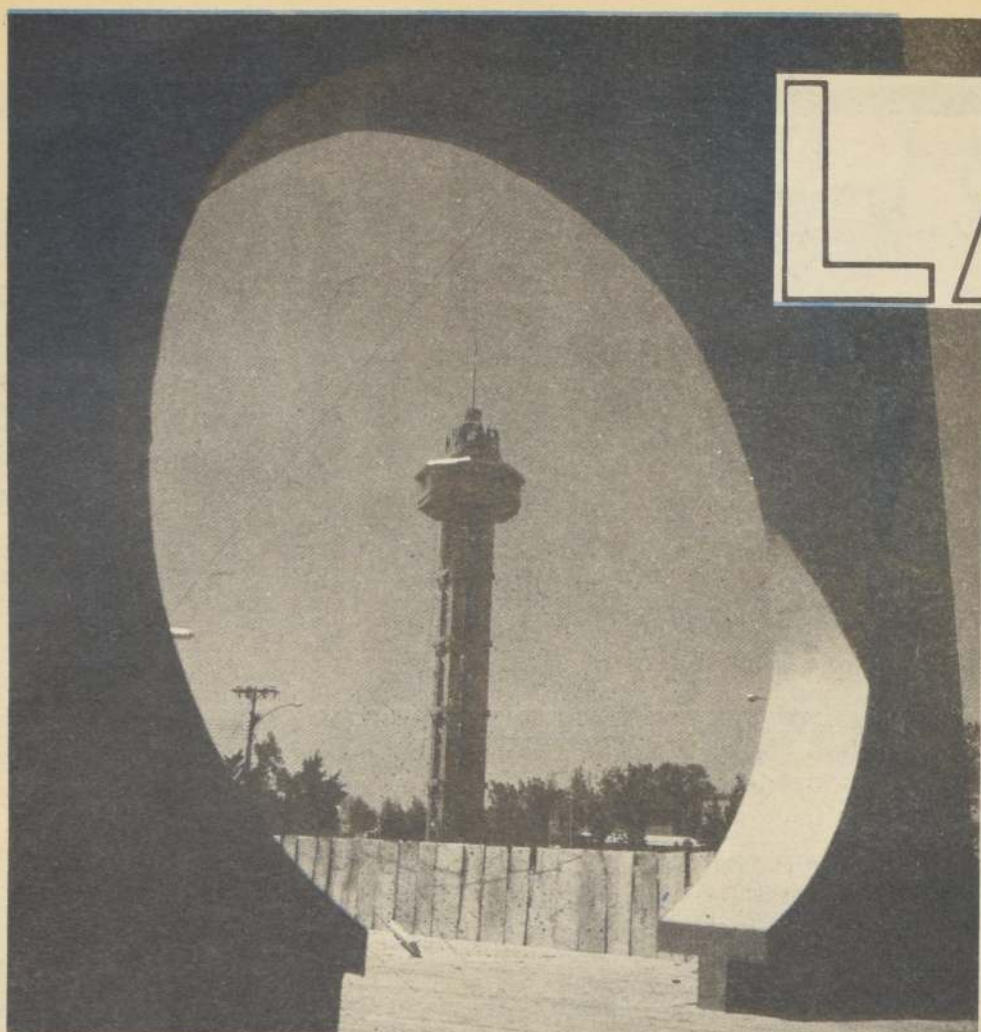
La Torre Mirador. De estructura metálica ubicada dentro de una fuente de agua. En el puente de acceso tiene un ascensor vidriado que conduce hacia el mirador que tiene 9 metros de diámetro. Tiene una altura total de 50 metros.
