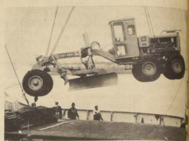
Desde las bodegas del carguero ANTARTICO es desembarcada la 20 motoniveladora Huber-Warco llegada a Chile por la Dirección de Vialidad e importada por Grace y Cia (Chile) S.A.
