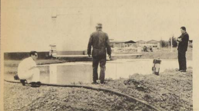
A JUICIO DE LOS TECNICOS el atentado terrorista pudo haber desintegrado Pudahuel a no mediar un error de cálculo. La bomba estalló junto al estanque de parafina que se derramó formando una verdadera piscina, afortunadamente sin inflamarse.
