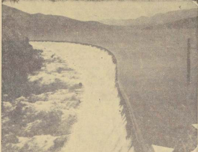
Una vista del tranque Recoleta, en el departamento de Ovalle, provincia de Coquimbo. Comenzado en 1929 y terminado en 1947, tiene una capacidad de 116 millones de metros cúbicos y sus características son: muro de contención de 47 metros de altura; canal de rebalse que puede contener un caudal igual al del río Mapocho; recibe sus aguas del río Hurtado y del río Limari, por medio de los canales Villalón, Tuqui y Alimentador.
