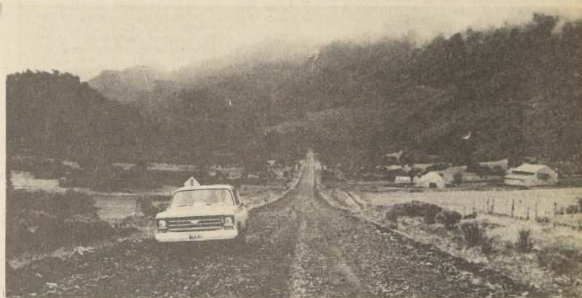
La construcción de dos villas para colonos junto a la carretera longitudinal austral ha programado el Ministerio de Obras Públicas, como una forma de integrar a estos lejanos habitantes al todo común que será Chile una vez que la ruta esté concluida
