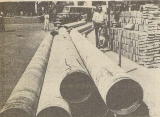
Los trabajos de alcantarillado que se realizaron en las comunas, permitieron a los pobladores evitar por fin los graves problemas de higiene, contaminación y desbordes.
