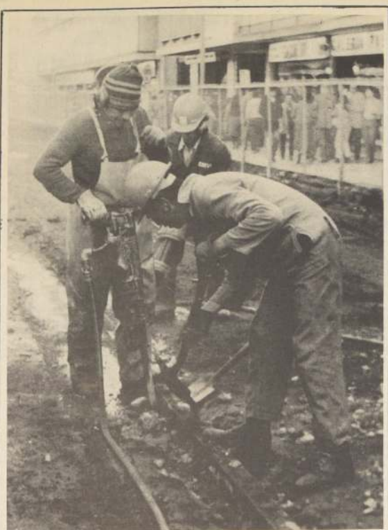
A fines de diciembre deberá quedar terminado el trabajo de alcantarillado de aguas servidas en la comuna de Concepción.
