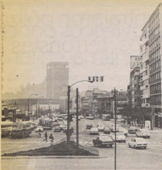
Un importante proyecto destinado a agilizar el tránsito ejecutará el MINVU en el eje Vicuña Mackenna iniciando las obras en el sector Plaza Italia.
