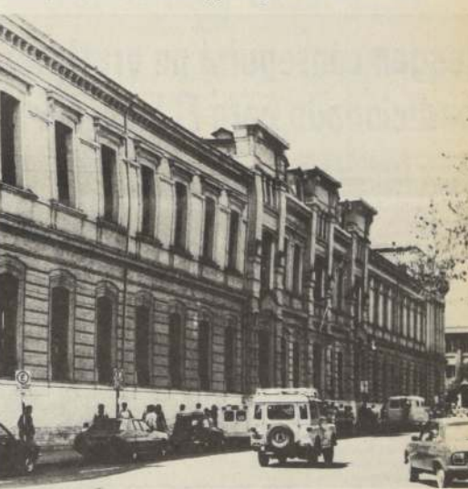
La antigua Cárcel Pública de Santiago, —cuya demolición se iniciará a mediados de este año— alberga a alrededor de dos mil reos, la mitad de los cuales son reincidentes.
