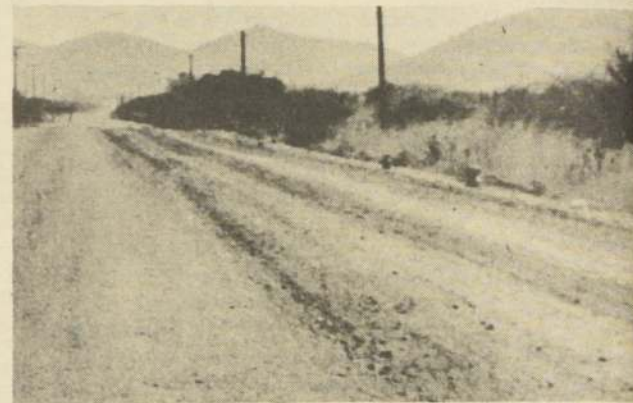
En el Tramo "Variante San Sebastián" del camino a Algarrobo, el peralte es muy poco pronunciado, lo que constituye un peligro para los vehículos.
