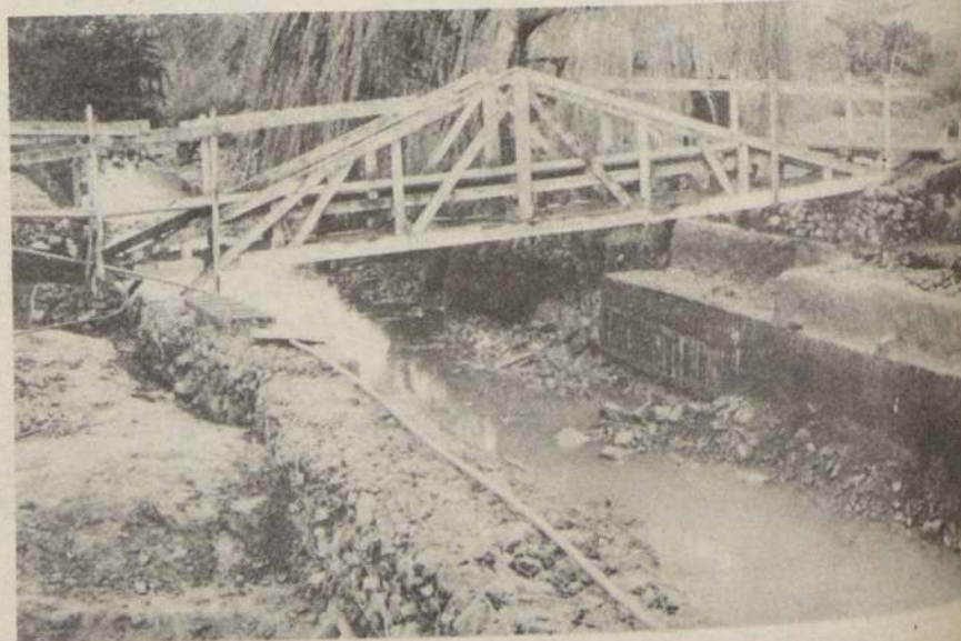
PUENTE LA CAÑADA
