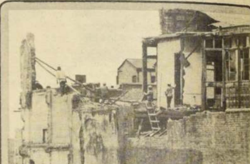
Es urgente demoler las casas que cualquier día pueden desplomarse sobre las habitaciones colindantes.
