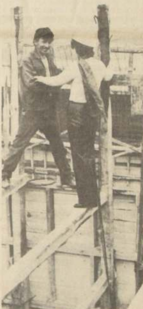
La captación de mano de obra de la construcción es uno de los factores de efecto directo que se retruoca como consecuencia de una detención de la actividad.
