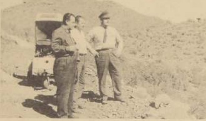
EL GOBERNADOR de Coquimbo, Héctor González Campuzano, desde una cima observa el duro trabajo comunitario realizado por un grupo de veintiseis cabreños, que construyeron una variante entre La Calera y Andacollo.
