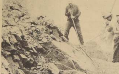
CAMPESINOS y mineros, aportando su trabajo personal, a golpe de chuzo y picota, construyen una variante que permitirá acortar el camino que va de Coquimbo a El Molle. La variante ejecutada por obra comunitaria tiene más de treinta y tres kilómetros.
