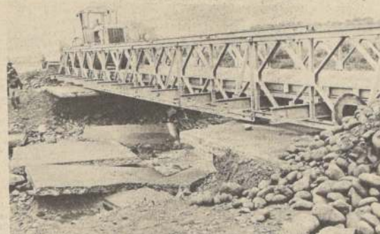
Puente provisorio "Bailey" en calzada derecha del Longitudinal, en uno de los puntos más afectados del estero, cerca de Angostura. (Foto de Gerardo González).
