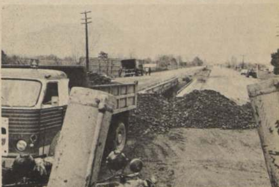
Personal de Obras Públicas repara una alcantarilla reventada y realiza levantamiento de la losa en el kilómetro 46 de la Carretera Longitudinal Sur. (Foto de Gerardo González).
