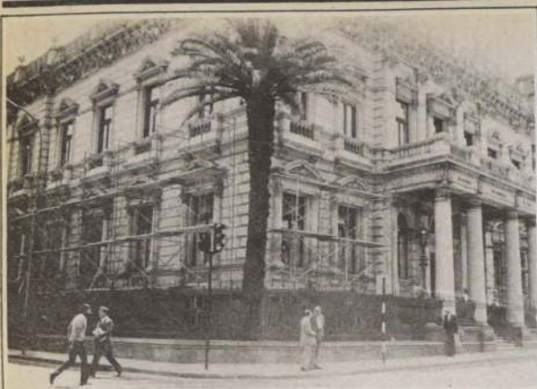
SE REMOZA LA ACADEMIA DIPLOMATICA. — El vetusto edificio, hoy la Academia Diplomática, del Ministerio de Relaciones Exteriores, se remozó. Se observa en la foto, el andamiaje que ya se está ubicando, para mejorarlo en su exterior y darle la prestancia que merece tan importante centro de estudios.
