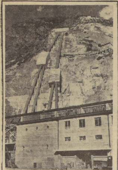
CASA DE MAQUINAS Y TUBERIAS DE LA CENTRAL HIDROELECTRICA LOS CIPRESES
