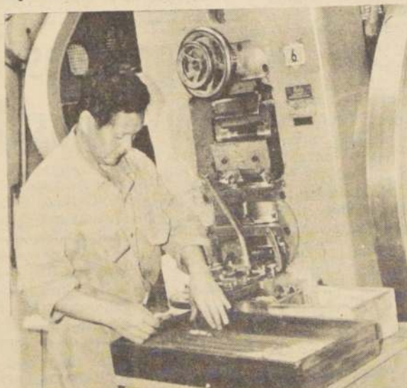
Prensa "Schuler" utilizada en la acuñación de las Medallas de la Reconstrucción Nacional.
