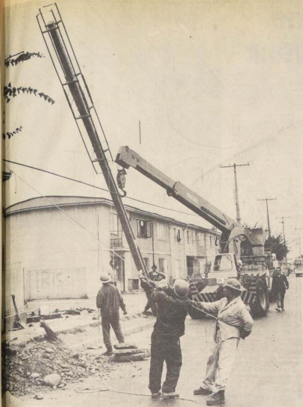
Personal de "Chilectra" instalando un poste de distribución en un sector de Santiago. El trabajo lo realizan con línea de viva tensión de doce mil volts.
