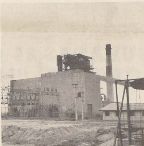
Unidad N° 1 de la Central Ventanas actualmente en servicio.
