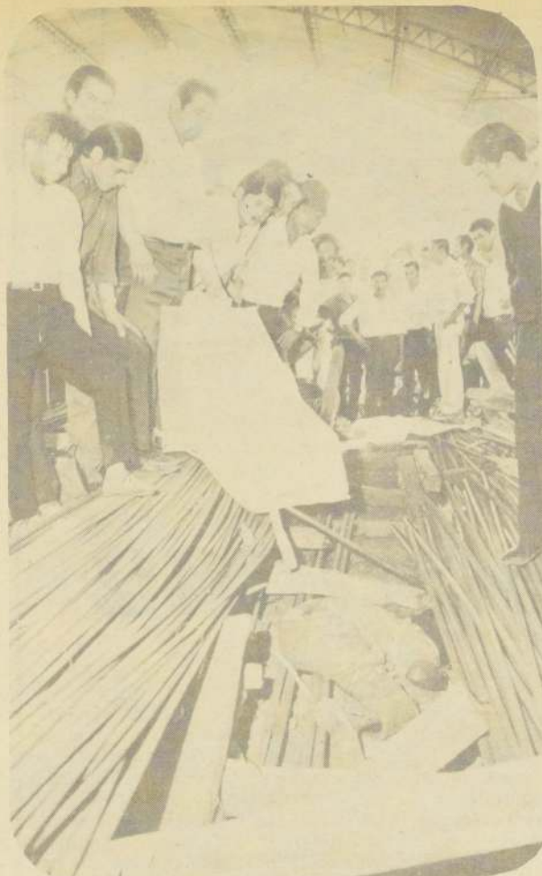
He aquí un típico accidente del trabajo, donde un jornalero murió junto a otro trabajador al ser aplastado por una pila de barras de hierro de 100 toneladas. Estos accidentes son cubiertos por Instituciones de Seguridad del Trabajo particulares y por el S.S.S. a través del S.N.S.
