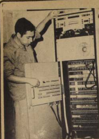
El PHOION o cerebro electrónico, descifra los códigos de las cintas perforadas por las teletipos, transformándolas en foto composición. Vale decir, en lo que usted está leyendo en estos momentos.
