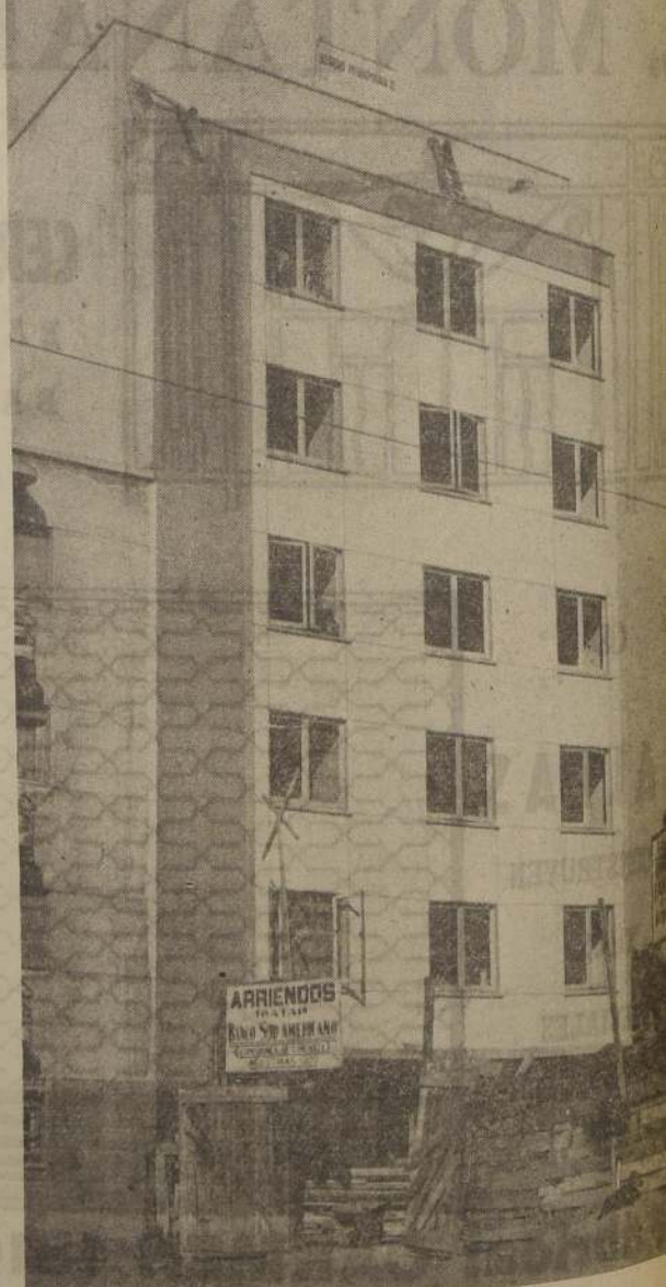
Edificio ABOGABIR Y CIA.
