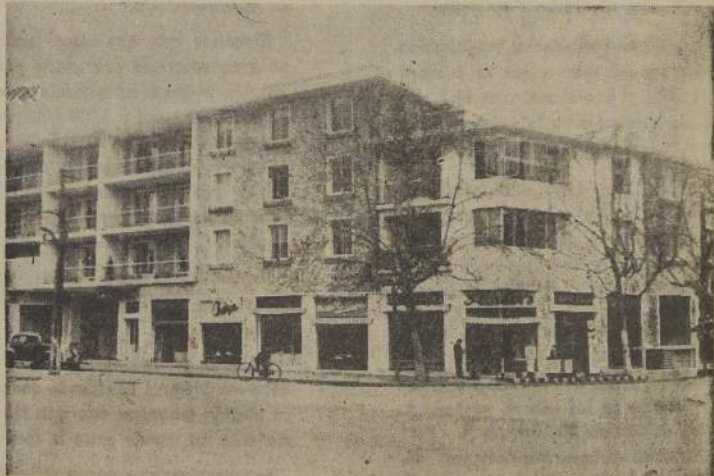
Aspecto del edificio "Eduardo Irarrázaval Sánchez", ubicado en Providencia esquina de Pedro de Valdivia
