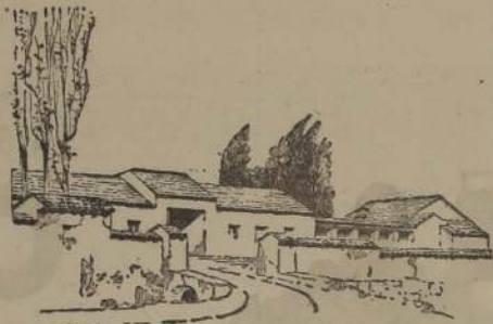
Antigua "casa" en los alrededores de San Felipe. Es una construcción típica "chilena" de la época colonial, como tantas que se encuentran diseminadas en el valle central.
