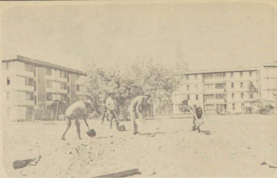
En la Villa los Presidentes los trabajadores del PEM transforman un terreno árido en un parque que a corto plazo hermoseará el recinto de la Avenida Grecia.
