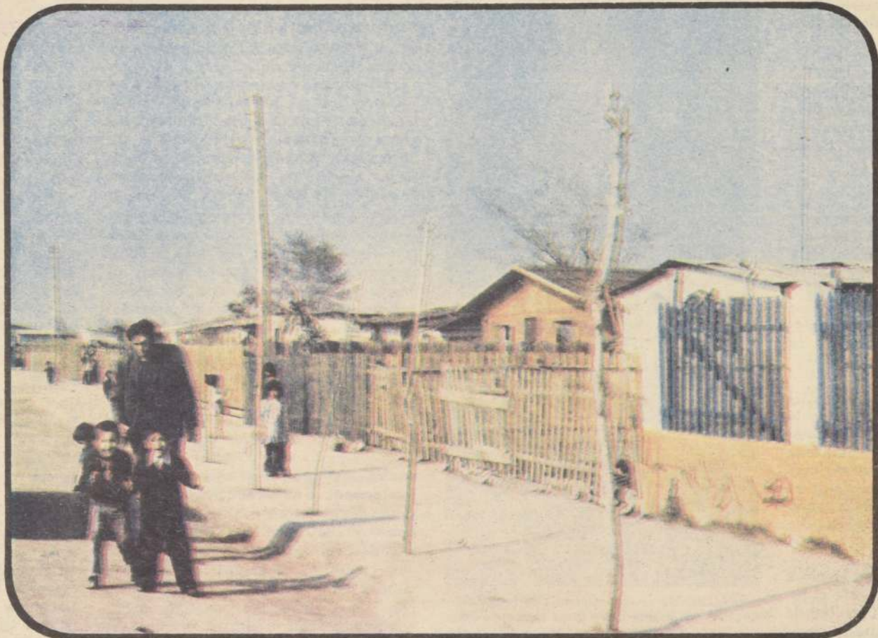
Desde ayer los pobladores del Campamento "Las 4 Estrellas" gozan en sus casas de luz eléctrica, al ser terminadas las instalaciones de acuerdo a los planes de electrificación para todos los Campamentos, ordenado por el Supremo Gobierno.
