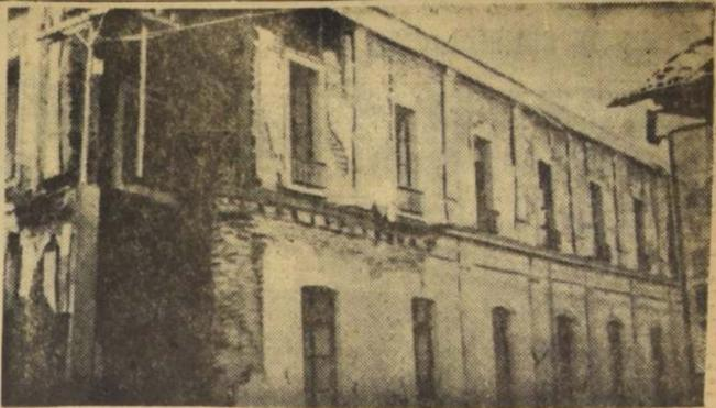
Ilustración 23. Efectos del terremoto sobre una casa de albañilería en la ciudad de Cauquenes. Chile. Durante el movimiento sísmico las dos fachadas tendieron a separarse, causando el derrumbe completo de la esquina, facilitado por la solución en ochavo, llevándose también el entramado de piso.
