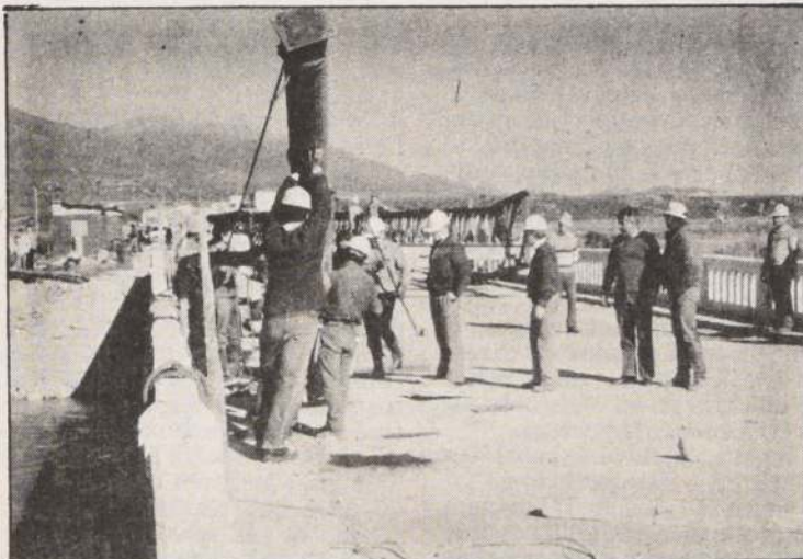
Con la instalación de una estructura metálica tipo ACROW sobre el deteriorado puente Conchalí, en el kilómetro 226 de la Ruta Cinco Norte, se agilizarán los trabajos de reparación de emergencia en el Huentelauquén, faena vital para habilitar el tránsito de los camiones de carga que llevan abastecimiento a la zona norte.
