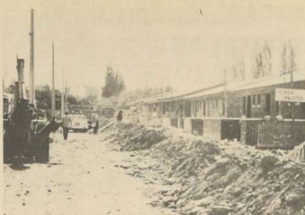
El próximo viernes 17 deberán estar terminadas las 198 viviendas básicas que está construyendo el SERVIU en Antofagasta, para familias de escasos recursos.
