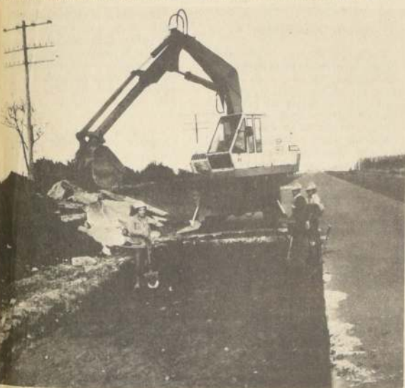
Trabajos de repavimentación de la Carretera Panamericana en la VII Región.
