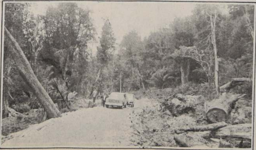
Enormes proyecciones representa para la Región de Aysén la construcción de la Carretera Austral "Presidente Pinochet". La obra tendrá un costo de 2.133 millones de pesos.
