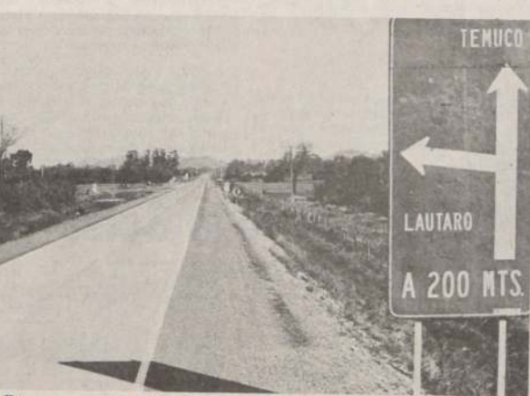
Este es un sector del tramo repavimentado del Longitudinal Sur que inaugura hoy el Ministro de Obras Públicas en Temuco.
