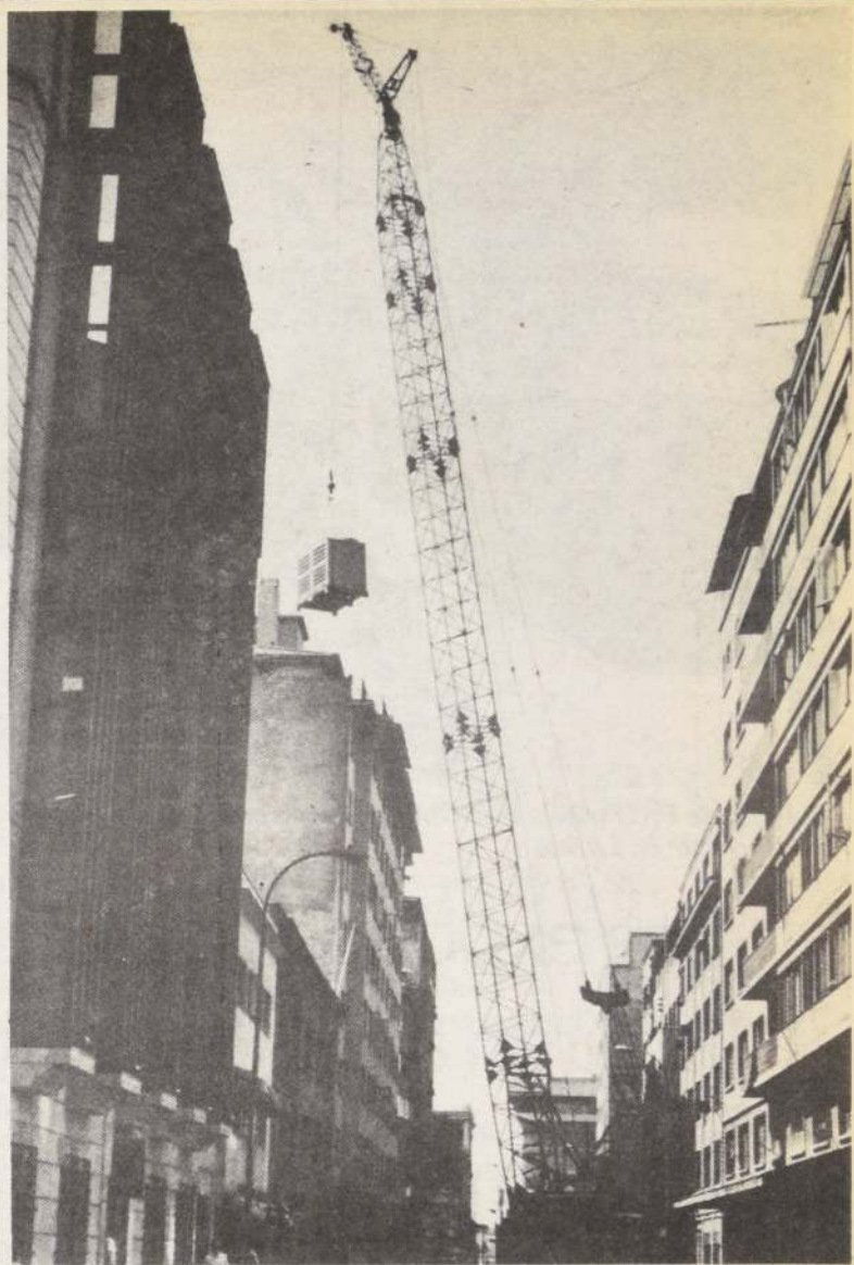
La instalación de tres enfriadores de agua en el edificio de la Comisión Chilena de Energía Nuclear requirió de la presencia de una grúa de 35 toneladas de peso y su impresionante pluma de 45 metros.
