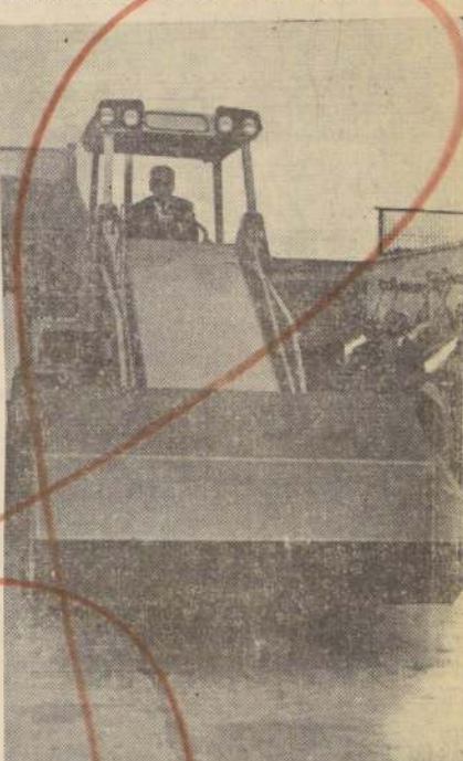
EL INGENIERO-JEFE del Departamento de Maquinarias del Ministerio de Obras Públicas, señor Heriberto Bargsted, efectúa una demostración de la eficiencia mecánica y de la capacidad de trabajo de los cargadores frontales Clark Michigan, con una de las modernas máquinas entregadas ayer por la firma DISTRIBUIDORA CUMMINS DIESEL (CHILE) LTDA. al Gobierno. La foto fue tomada durante el acto de entrega de las unidades destinadas a mejorar y construir caminos en las provincias del norte, centro y sur de Chile.
