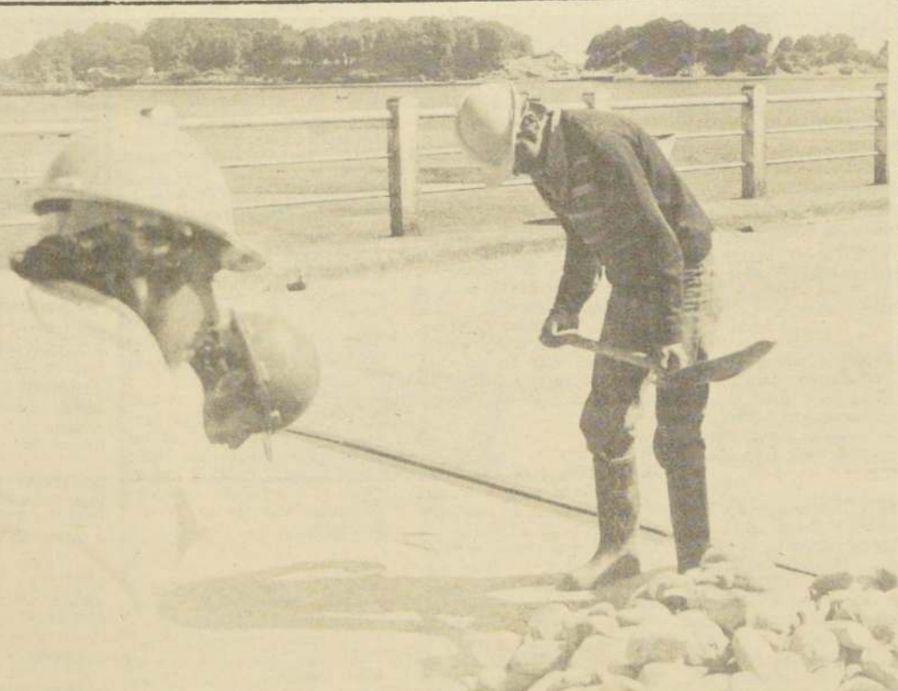
ANCUD.— El puente sobre el río Pudeto comienza ya a ser utilizado. Las obras de reconstrucción se encuentran en su etapa final.
