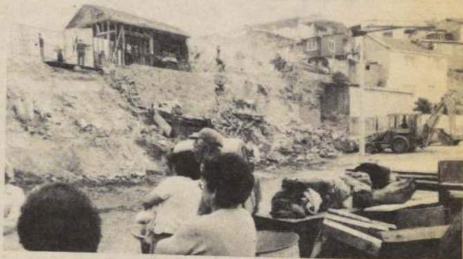
Mientras los damnificados cuidan sus enseres, personal del municipio viñamarino reconstruye una vivienda dañada por el sismo.
