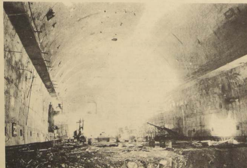
UN ASPECTO de la caverna de máquinas de la Central "El Toro", de 400.000 KW ubicada en el Laja. Las
