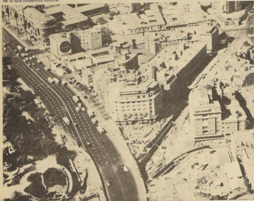
TUNEL SANTA LUCÍA. Se iniciaron los trabajos en Enero, y se entregará a fines de Junio. Su costo es de $10.000.000.
