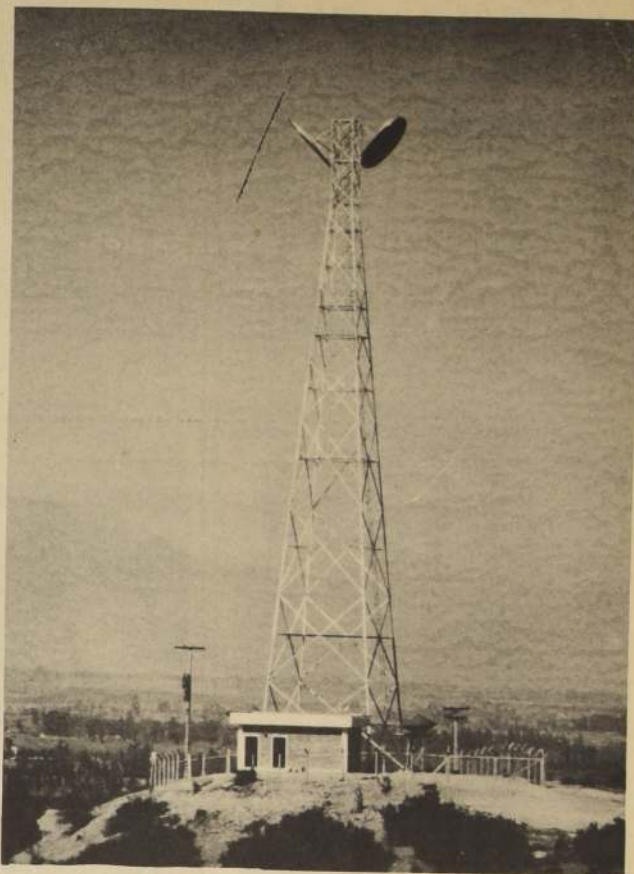
Repetidor de microondas "La Requingua" del sistema terrestre de comunicaciones por satélite.
