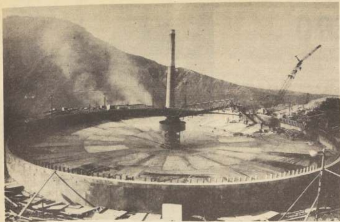
Uno de los complejos del mineral de El Teniente, donde los trabajadores se esfuerzan, día a día, en considerar aspectos diversos relacionados con el trabajo mismo de producción y problemas de nivelación de salarios.
