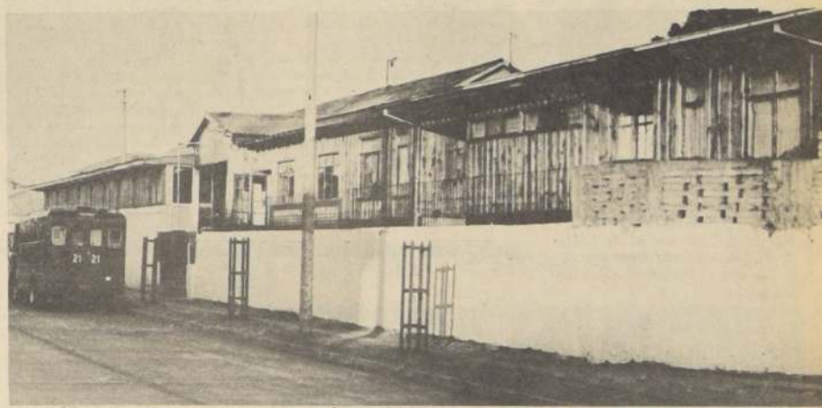
Esta es la poco atractiva fachada de la cárcel penquista en calle Chacabuco 70, que será demolida para dar paso a una remodelación del sector.
