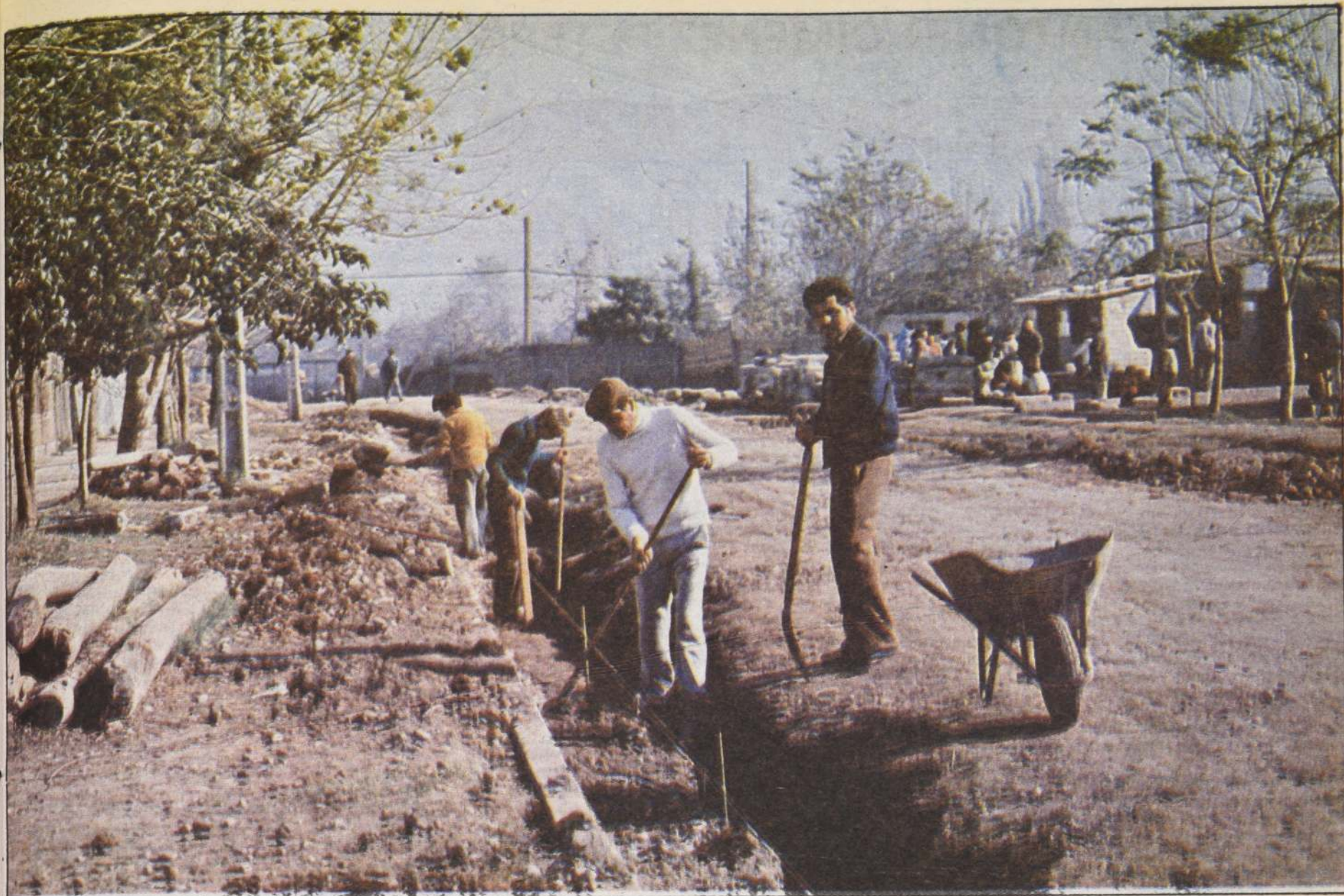
Trabajos de pavimentación y de reparación de calles y alcantarillado son las características del Renca de hoy.
