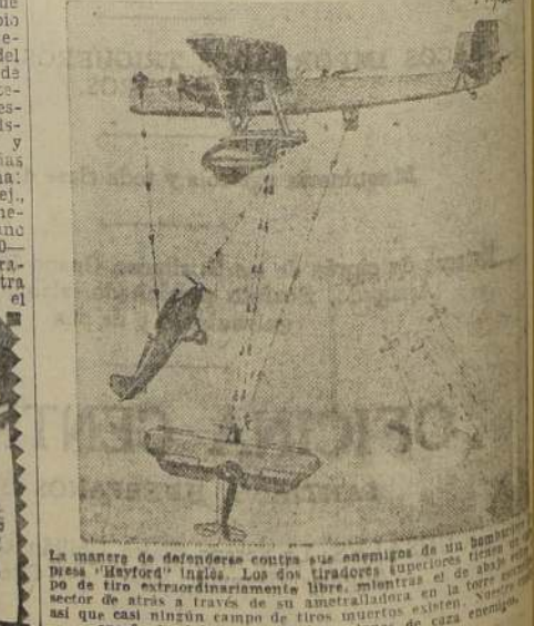
La manera de defenderse contra los ataques de un bombardero pesados "Mayford" inglés. Los dos tiradores superiores tiran un po de tiro extraordinariamente libre, mientras el de abajo, situado de atrás a través de su ametralladora en la torre superior, así que casi ningún campo de tiro, mientras existen, y enseñando la defensa contra los aviones de caza enemigos.
