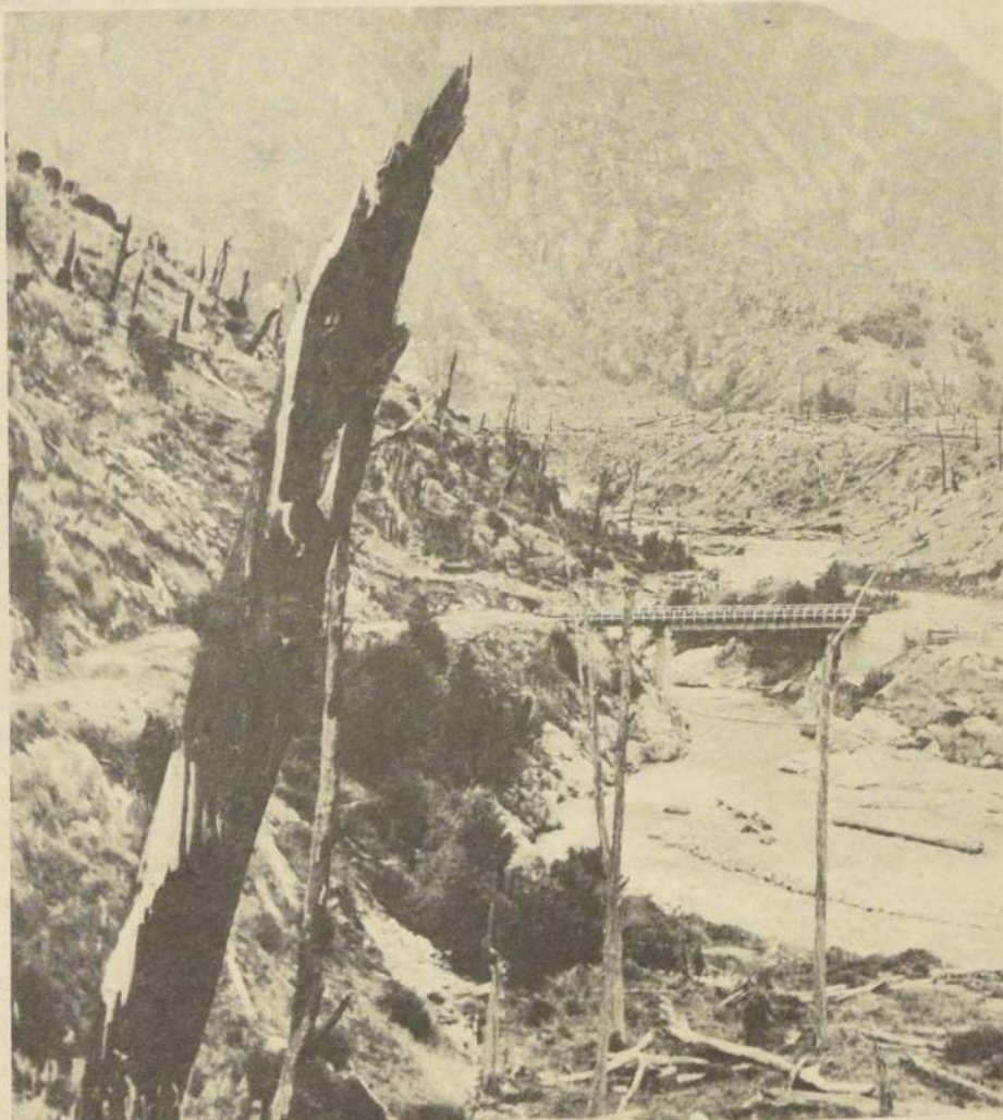
En diversos tramos, la construcción de la Carretera Austral “Presidente Pinochet” prosigue intensamente.
