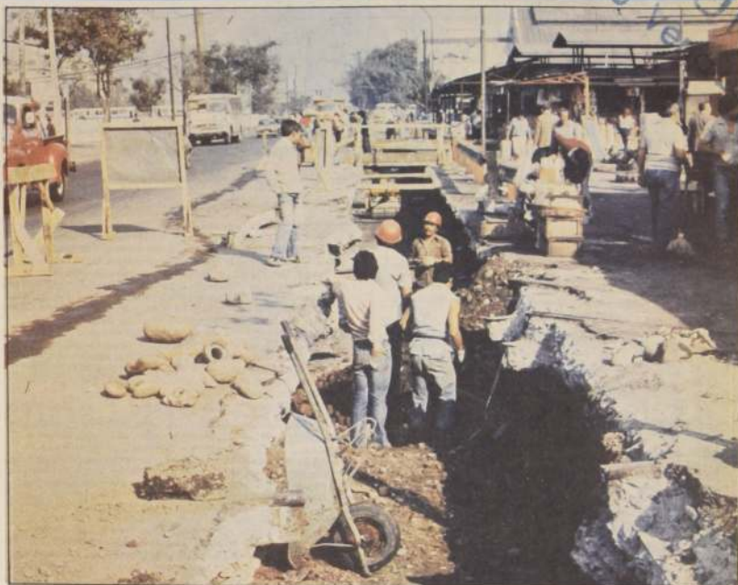
FUERTE INVERSION EN MEJORAMIENTO DE AGUA POTABLE
