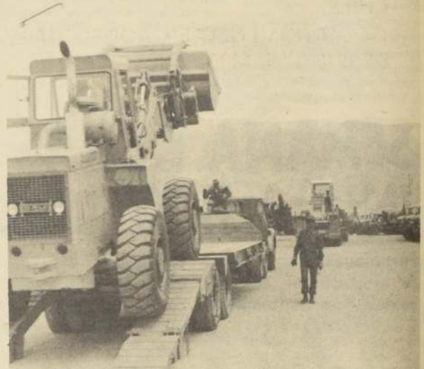
Parte de la maquinaria con que el Comando de Ingenieros del Ejército construirá caminos y realizará otras obras públicas y de carácter social en la Provincia de Chiloé. El equipo se encuentra en viaje hacia el sur bajo la dirección del Teniente O'Higgins Bravo Sandoval.
