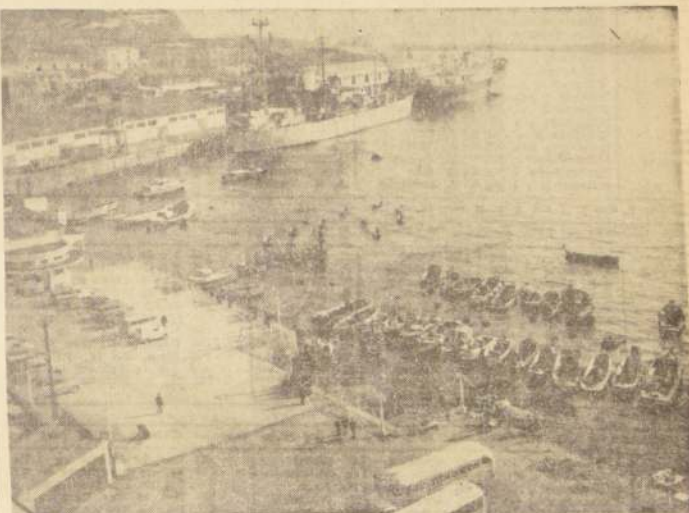
La Bahía de Valparaíso muestra junto al paisaje, un trabajo ordenado, gracias a la reorganización de las actividades que ha impuesto la Empresa Portuaria de Chile. EN EL GRABADO se puede apreciar una vista panorámica de la Bahía, con los barcos atracados al espigón, para la carga y descarga de sus fletes.
