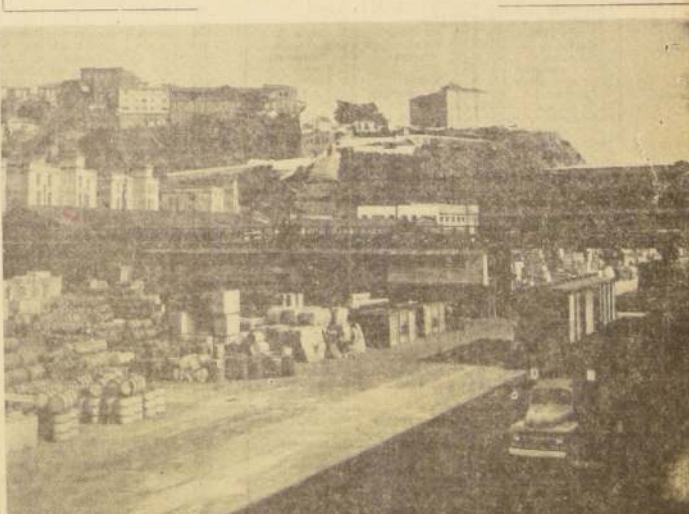
El trabajo que está realizando la Empresa Portuaria de Chile permite que los recintos de los puertos se vean libres de los atachamientos que eran característicos de esos sectores. EN EL GRABADO, se puede apreciar la forma ordenada en que se desarrollan las actividades en el puerto de Valparaíso.
