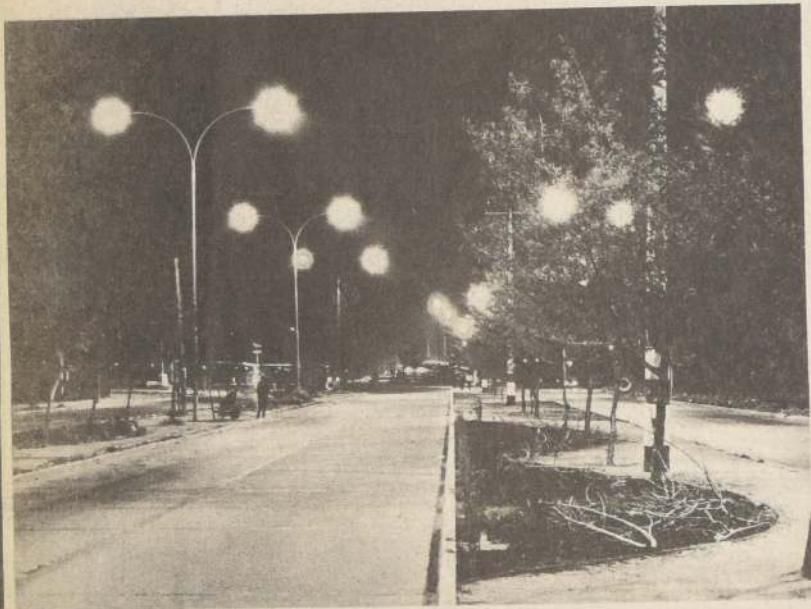
Alumbrado público en Av. Américo Vespucio, aproximadamente 5.000 ml, entre calles Punta Arenas al Oriente y San Francisco al Poniente. Consiste en postes de 12 metros de altura libre con luminarias de Sodio de 400 watts alta presión y celda fotoeléctrica.
