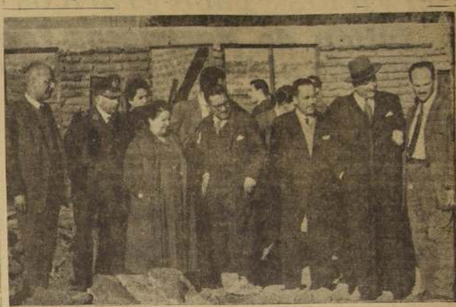
En la tarde de ayer, la Primera Dama, señora Graciela Letelier de Ibañez, concurrió a la inauguración de los tijerales de la nueva Población "Lo Franco", que la Fundación de Viviendas de Emergencia está levantando en la calle Embajador Gómez esquina de Otto Lenghi, en Carrascal. Al acto asistieron la vicepresidenta de la Fundación, señora María Teresa Koch Ibañez, el Subdirector del Cuerpo de Carabineros, general Tulio Vidal; autoridades de la comuna y numerosas otras personas. Esta población estará formada por 130 casas de dos pisos y 200 casas de un piso, con un costo que se estima superior a los 330 millones de pesos, y es construida por el contratista Luis Prieto Vial. En el grabado, la señora Letelier de Ibañez observa como se levanta el primer tijeral.
