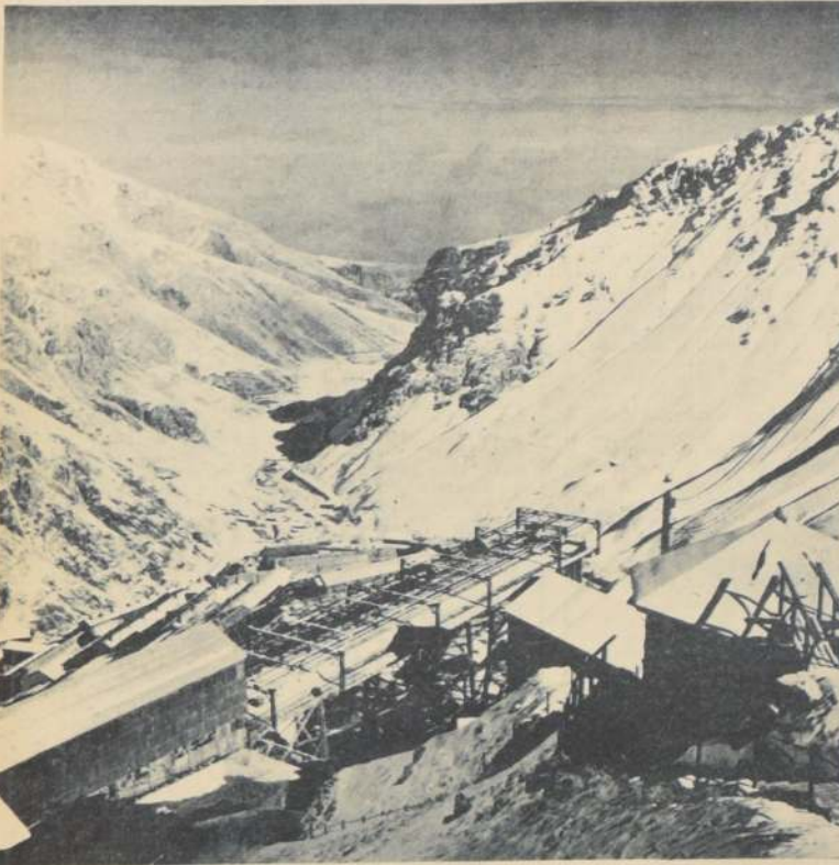
El Mineral de "El Teniente" es uno de los más avanzados tiene sus proyectos de ampliar la capacidad de producción. Se estima en un año el adelanto logrado en la construcción. En el grabado un aspecto de la estación terminal del ferrocarril de la mina a la Planta en Sewell.
