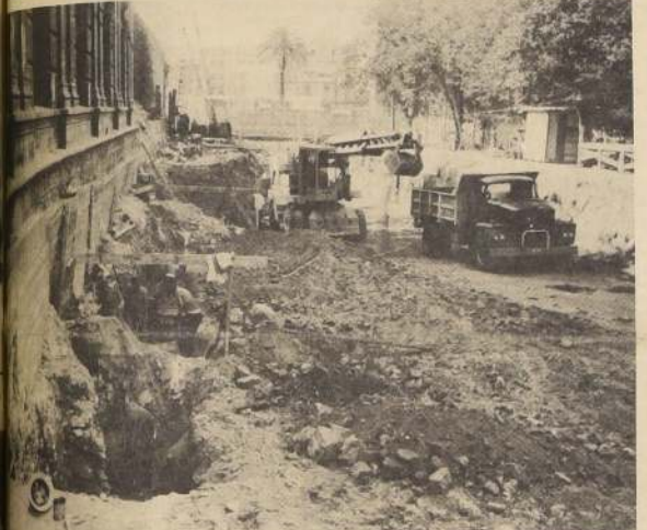
Trabajos de excavación en el costado del Cerro Santa Lucía han obligado a realizar poderosos rellenos en donde se asienta la vieja construcción del cerro.
