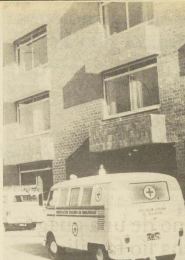
Sector de ambulancias y aspecto del Hospital del Trabajador de Concepción, establecimiento asistencial que será inaugurado por el General Pinochet durante su próxima visita a Concepción.
