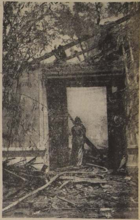
Bomberos retiran los escombros, después de haber sofocado el incendio en Lincoyán 531, en el que resultaron siete heridos y cuantiosas pérdidas.
