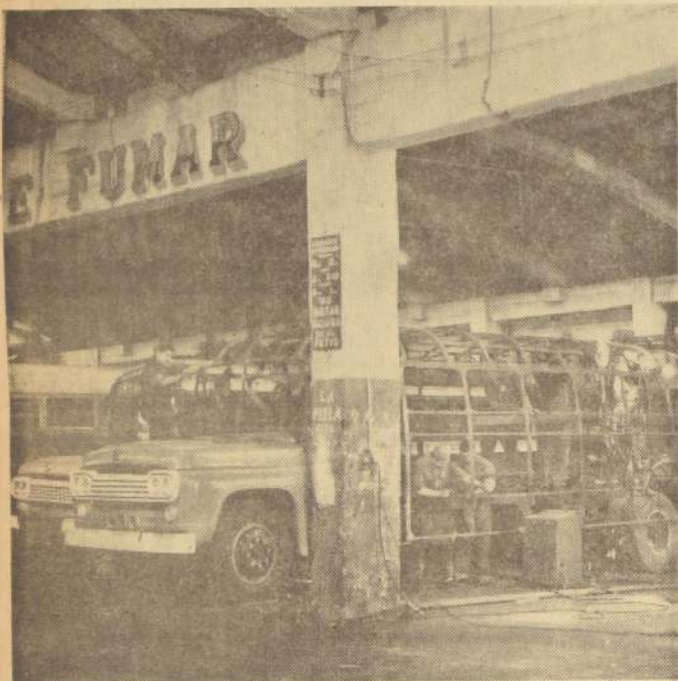
La Empresa PULLMAN BUSES tiene su propia fábrica de carrocerías en el interior del garaje de Cinco de Abril. Allí son carrozados los chassis que se importan, y, a la vez, reparados aquellos que sufren desperfectos. Un seleccionado personal realiza estas labores. EN EL GRABADO, en pleno trabajo de esta sección en un chasis modelo 1960, que en breve aumentará la dotación en funcionamiento.
